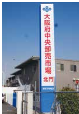
完成した北門サイン塔
