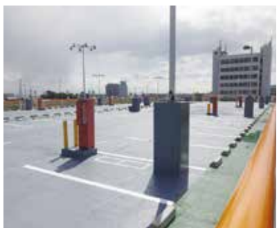
完成した立駐塗膜防水改修青果Aブロック
