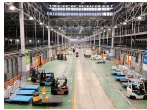
【卸売場西棟：入荷用通路3車線、左右に定温卸売場(幅員20m、延長220m道路で10tトラックが20台停車可能)】
