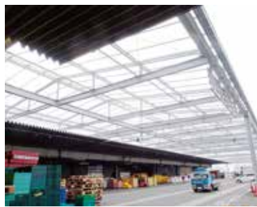
梁が完成し、あとはテント張り工事のみ。大屋根内には10t車も入り、効率よい事業展開が可能となる。
