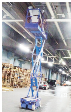
(水産大通りのLED工事)
